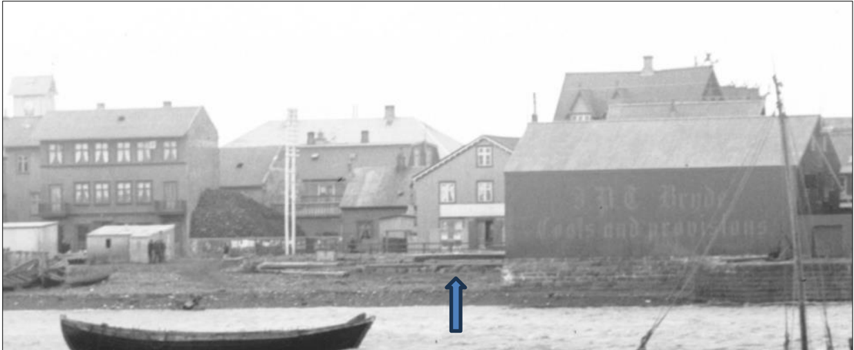
Mynd 7. Hluti af mynd 6. Naustin 1, pakkhús Brydeverslunar til hægri, og vestan við það má greina tvo garða á fremri greinilega hlaðinn úr tilhöggnu grjóti (5-284) en sá syðri gæti verið úr torfi og grjóti (5-83), upp af þeim er húsið Hafnarstræti 4. 16
